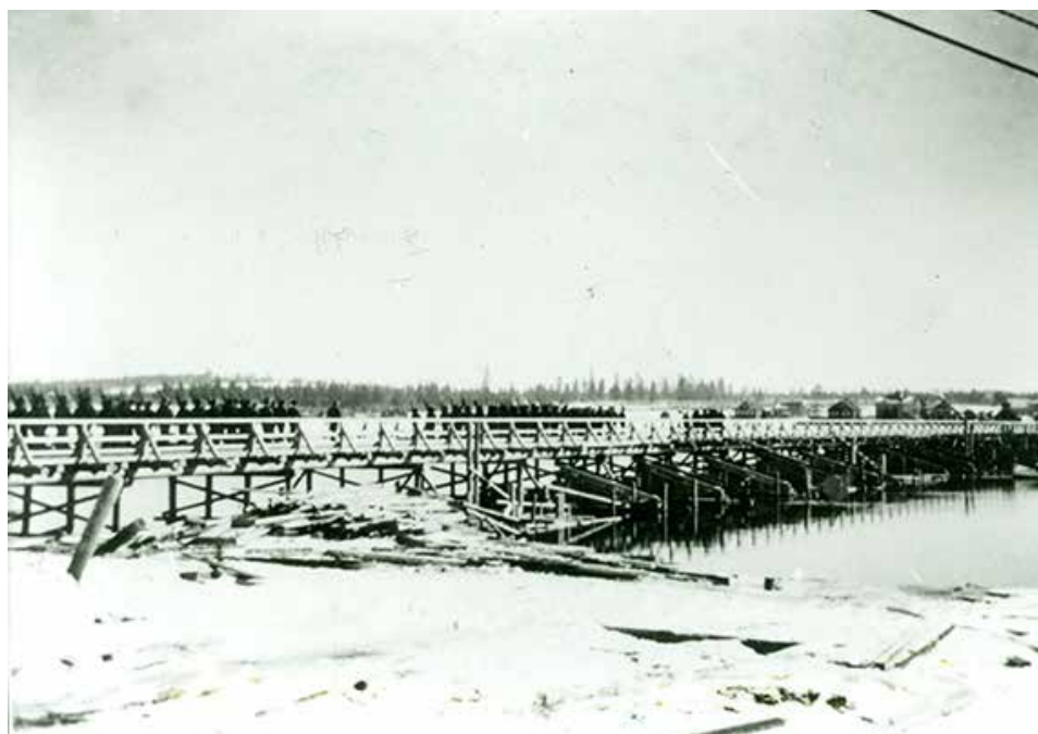
Pidman silta Syvärin yli. Tämän sillan Antti Henttonen ylitti neljä tuntia ennen sen sortumista vetäytyessään viimeisten joukossa Syvärin sillanpäästä.
