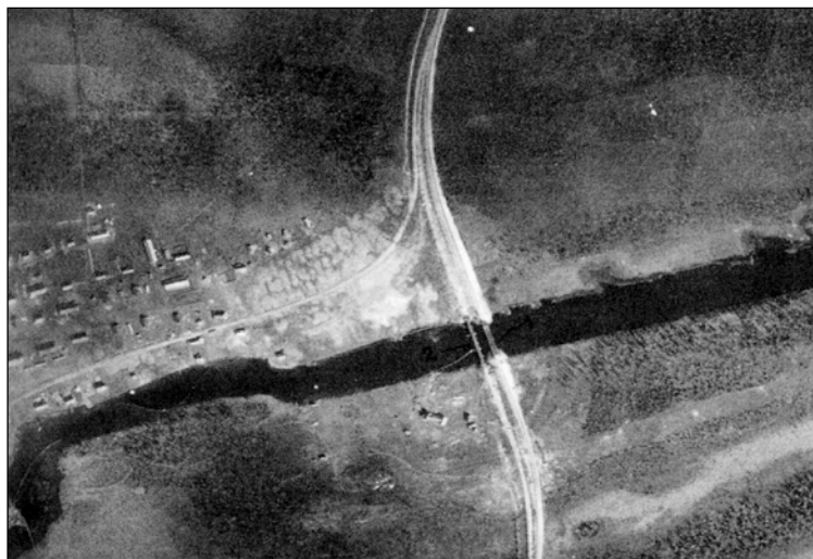
Muurmannin radan katkaisu, sillan vieressä varikkoalue ja varasillan osia.
