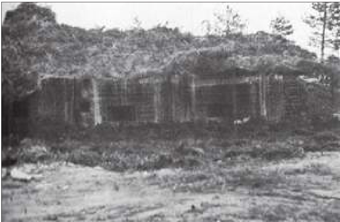
Toinen Summan kahdesta betonikorsusta syksyllä 1939 naamiointivaiheessa.
