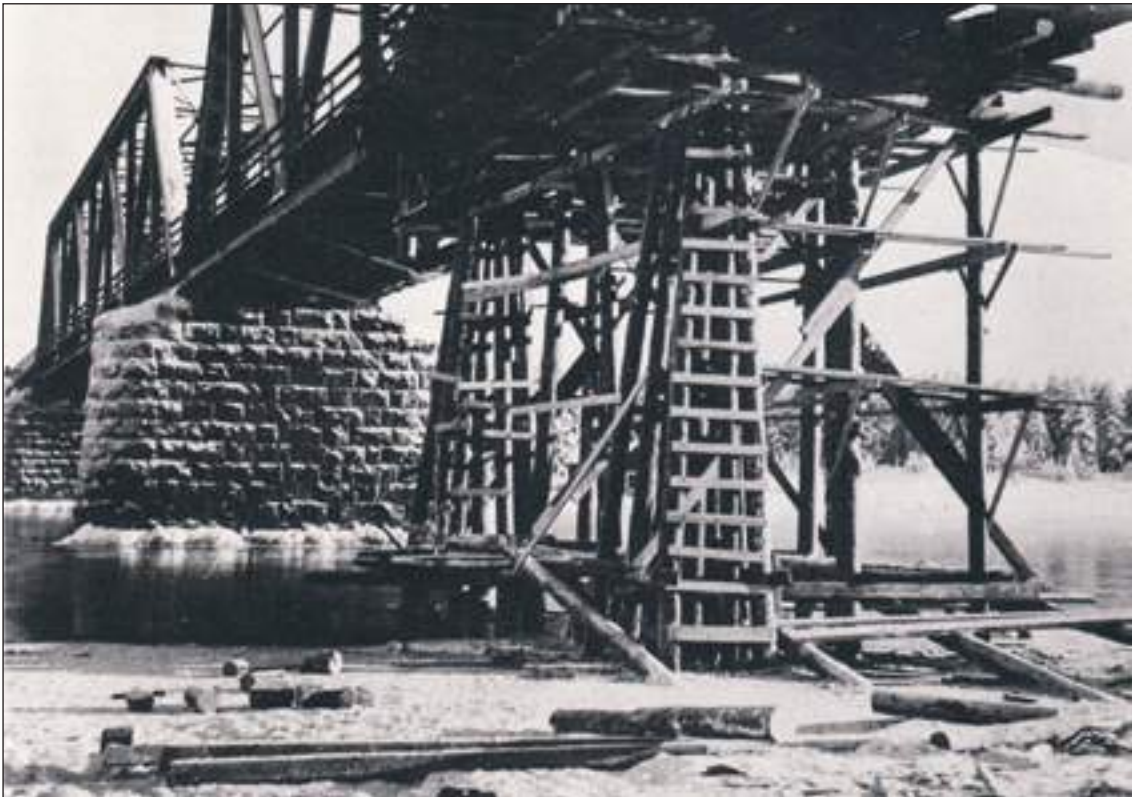
Kuvassamme 10.RKK:n korjaama Vaalan rautatiesilta Oulujoella. Jo YH:n aikana oli perustettu kymmenen radankorjauskomppaniaa.
