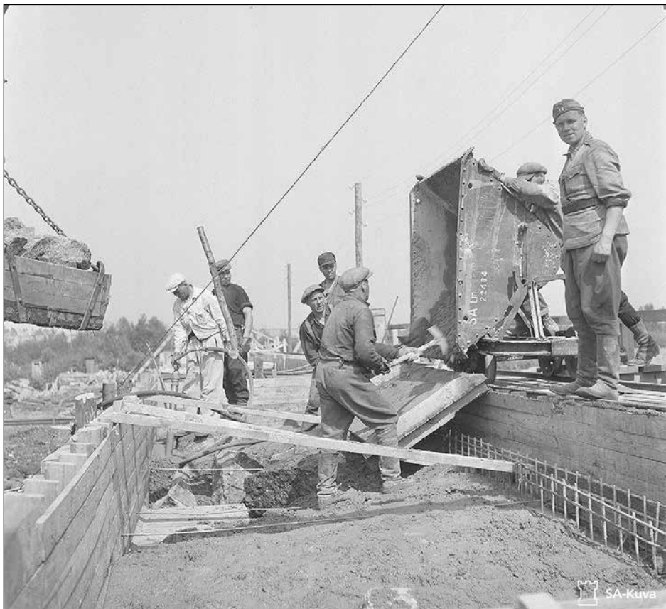
Betonin valua panssarivaunuesteen rakennustyömaalta Viipurin Maaskolan rata-pihalla 10.6.1944.
