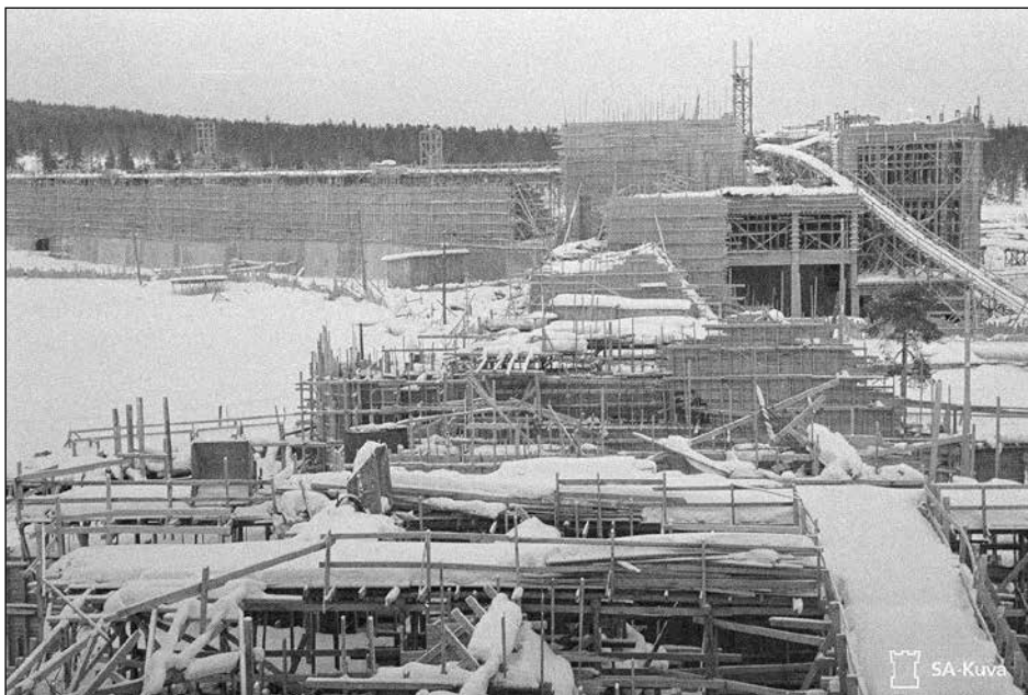
Mikkeli Oy:n patolaitteita Jäniskoskella 1.4.1940.
