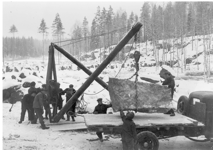
Salpa-linjan rakentaminen sen ajan työkoneilla oli raskasta työtä.
