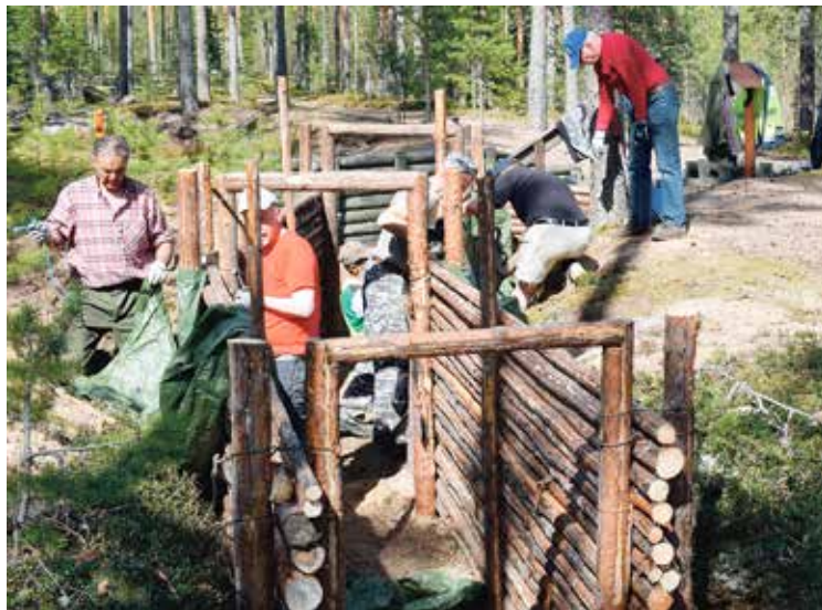
Rauhanturvaajat rakentavat taisteluhautaan puuverhousta Virolahden Bunkkerimuseolla.
