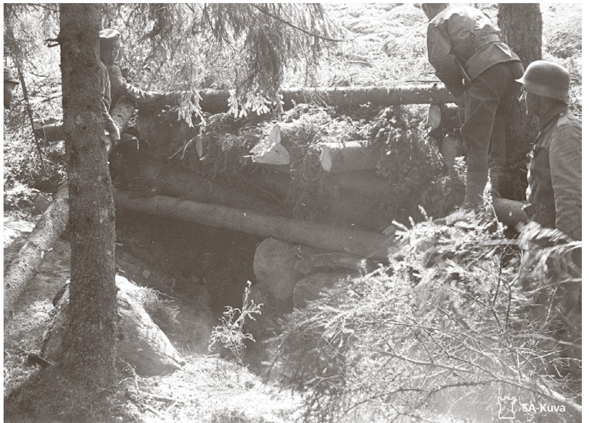
Sotilaat rakentamassa korsua
