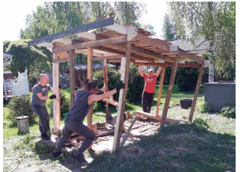
Luontoveljet purkamassa Hämeenlinnassa varastorakennusta.
