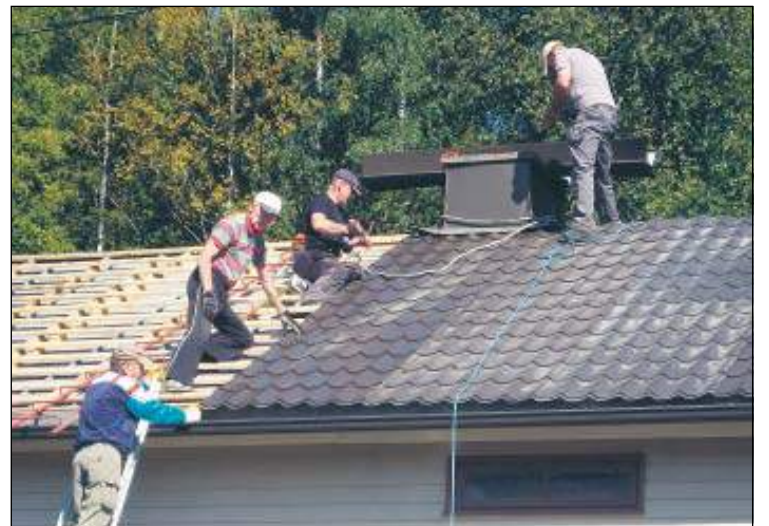
Sotainvalidin lesken talon kattoa korjataan Vaajakoskella.
