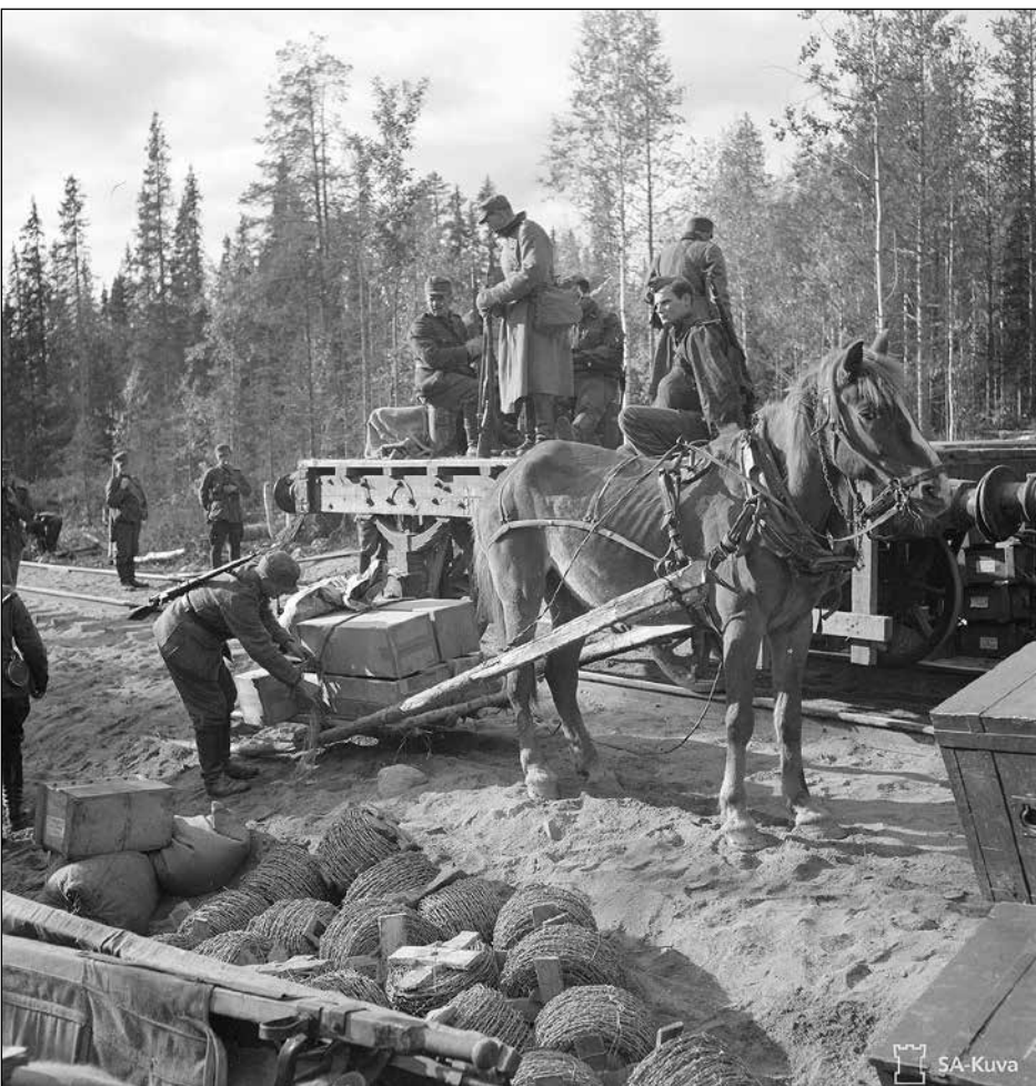
Junasta lastataan tarvikkeet purilaisiin, joilla tavarat viedään etulinjaan. Kiestingin-Louhen rautatie, 19.9.1941. Kuvassa näkyy mm. M-sarjan soravaunu, josta on poistettu laidat ja lisätty sivulle tikkaat lavalle kiipeämistä helpottamaan. Kuva: SA-kuva
