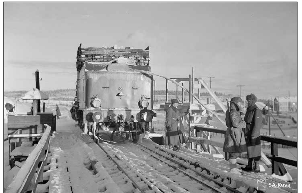
Karhumäen rautatiesillalla veturi ottaa vettä Kumsa-joesta, Karhumäki 24.12.1941. Vihollisen tuhattua vetureiden vedenantolaitteistot jouduttiin vedenhankinnassa erityisjärjestelyihin. Huomionarvoista on, että vedenantopaikkoja tarvittiin veturista ja junasta riippuen noin 50-90 kilometrin välein. Kuva: SA-kuva
