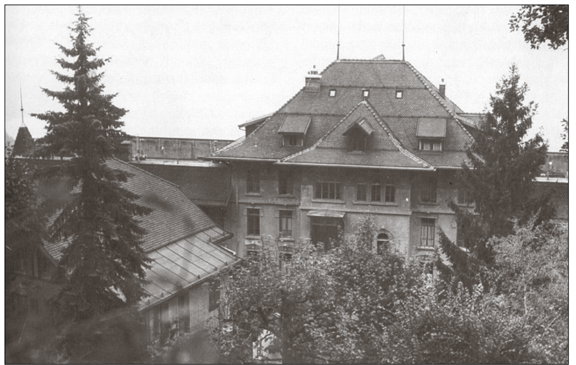
Val-Montin parantola. Marsalkan toisen kerroksen huoneen ikkuna on vasemmalla puiden takana. Parvekkeelta avautui näköala Geneven järvelle. Kolmannessa kerroksessa olivat hänen työhuoneensa.
