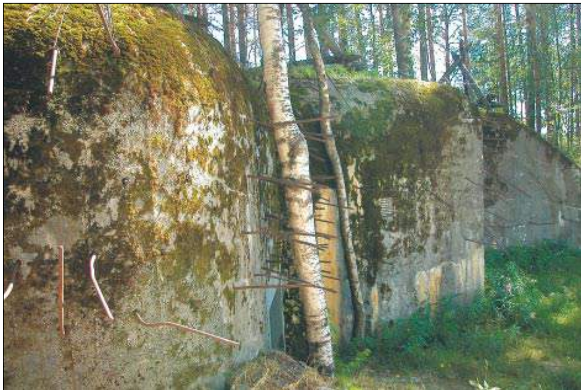
Teräsbetonikorsun jyhkeää seinää. Korsun rakentamiseen on käytetty 250 tonnia sementtiä ja 1 000 tonnia hiekkaa, sekä tietämätön määrä terästä.
