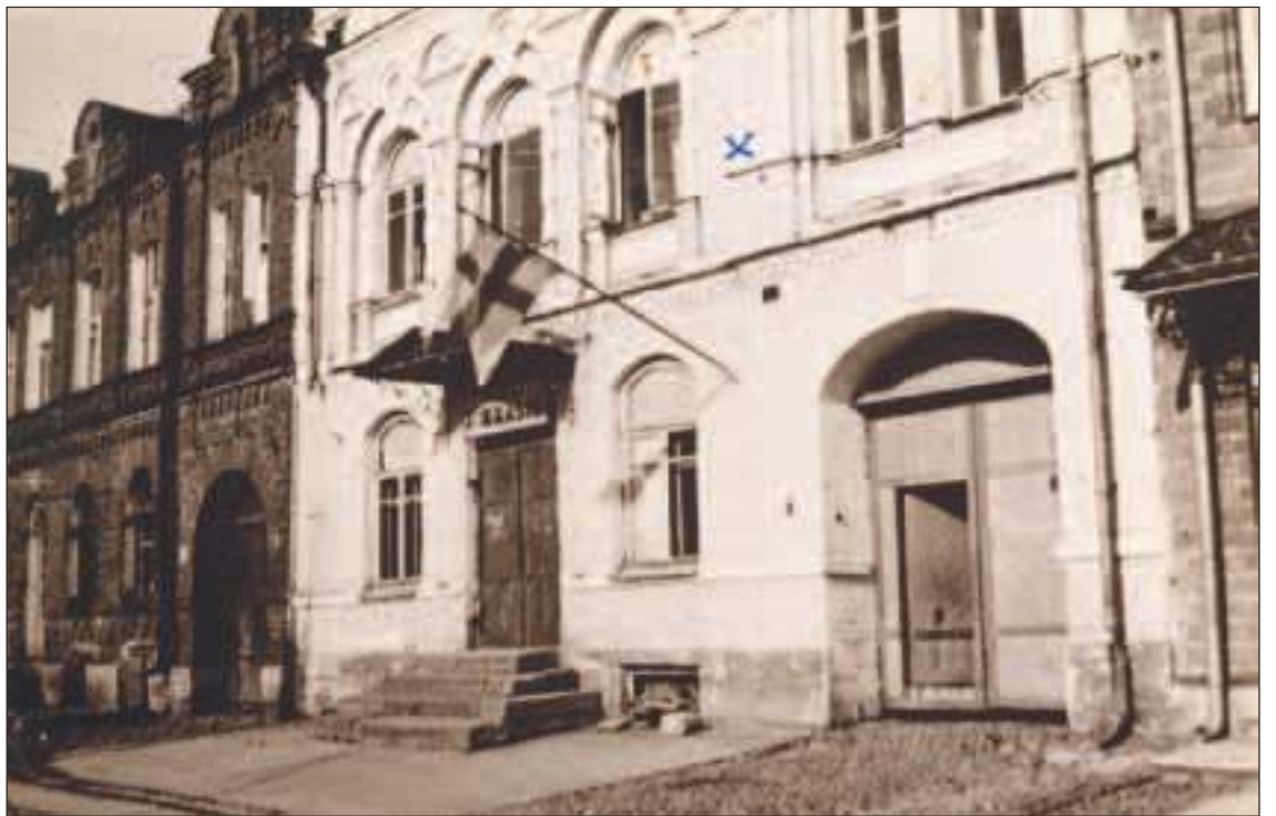
Kaasikin perheen talo Narvassa toukokuussa 1942. Auki olevat ikkunat toisessa kerroksessa olivat suomalaisten radiohuoneen (vas. olevat ikkunat ristillä merkitystä paikasta). Kuva: Jaakko Valtanen
