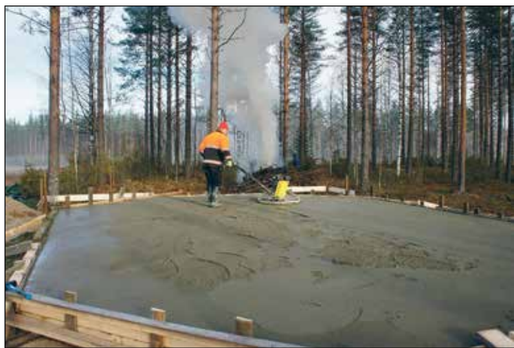
Jukolan Motin kodan pohja valettiin 17.10.2014. Valua tasoittamassa työmaan vastaava työnjohtaja Matti Kilpeläinen, jonka isä on Rukajärven suunnan veteraani.
