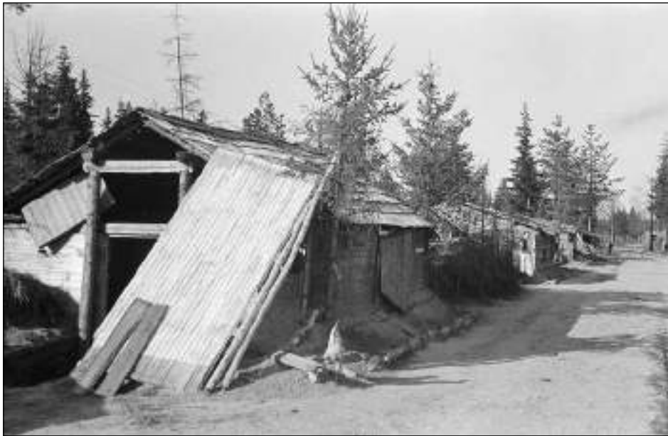
Venäläisten rakentamaa korsualuetta Lahdentakana kesällä 1945. Korsut toimivat väliaikaisina asuntoina, kun kuusamolaiset palasivat evakosta ja heidän kotinsa oli poltettu. Korsut oli rakennettu puretusta puutavarasta saksalaisilta polttamatta jääneistä rakennuksista sekä parakkilevyistä.
