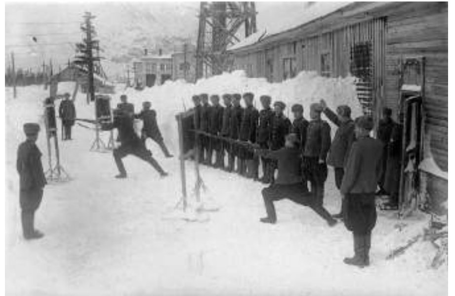
Pistimen käyttöharjoituksia. Ennen Vorkutan hiilikaivosalueen kapinan murskaamista harjoituksia näytettiin vangeille. Kuva: Jukka Rislakin arkisto.
