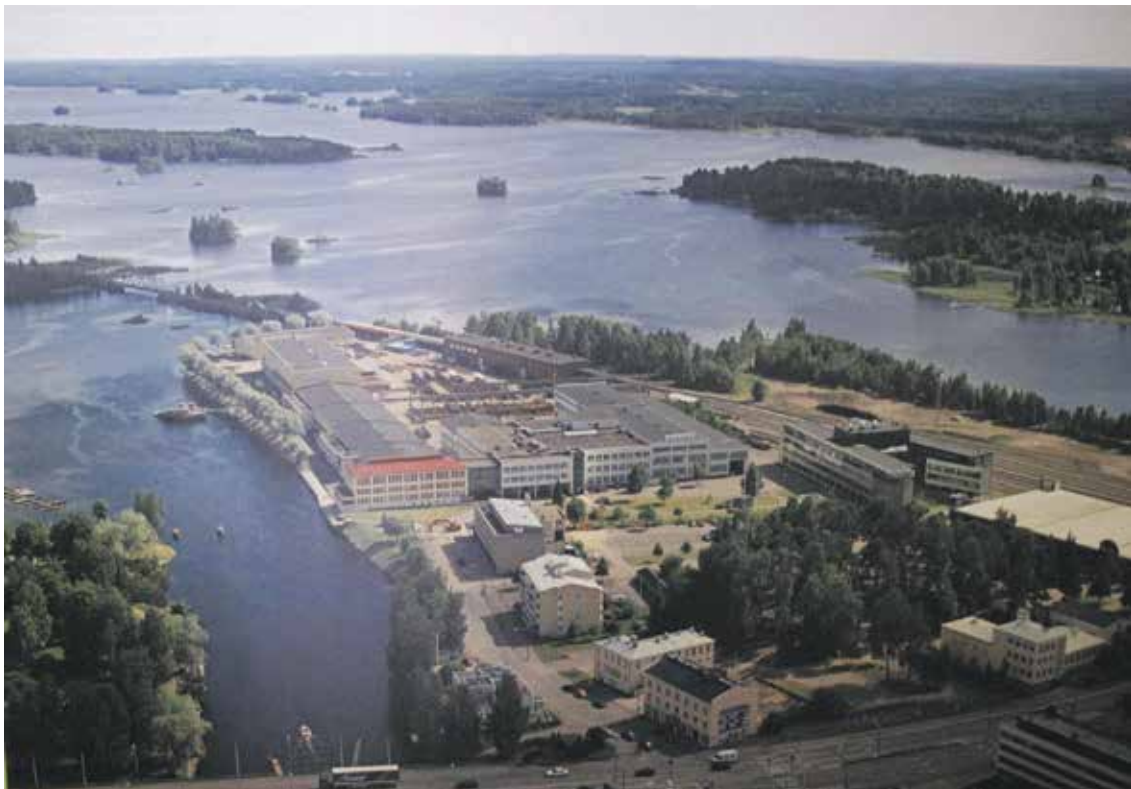
Sodanaikainen panssarikorjaamo on nyt teollisuuskäytössä.
