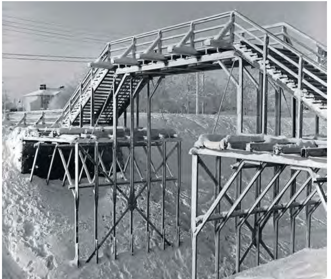
”Huokausten silta” Lappeenrannassa. Kävelysiltaa jouduttiin korottamaan sotakorvausjunien kulun mahdollistamiseksi. (Kuva: Lappeenrannan museot)
