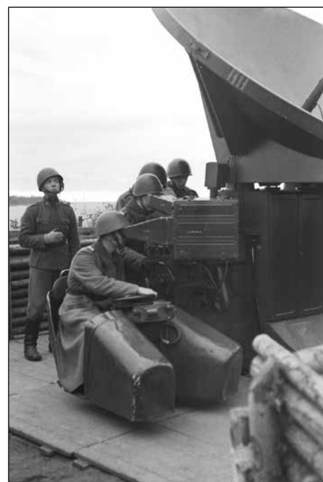
Irja-radioluotaimet (tulenjohtotutkat) olivat ratkaiseva ase yötorjunnassa. Niiden avulla johtopatterit (4) tulittivat viholliskoneita tehokkaasti, ja niiden avulla myös sulkuammunnalla oli suurempi pelotusvaikutus. Kuvassa Irja-miehistö toimi toimissa. (SA-kuva)
