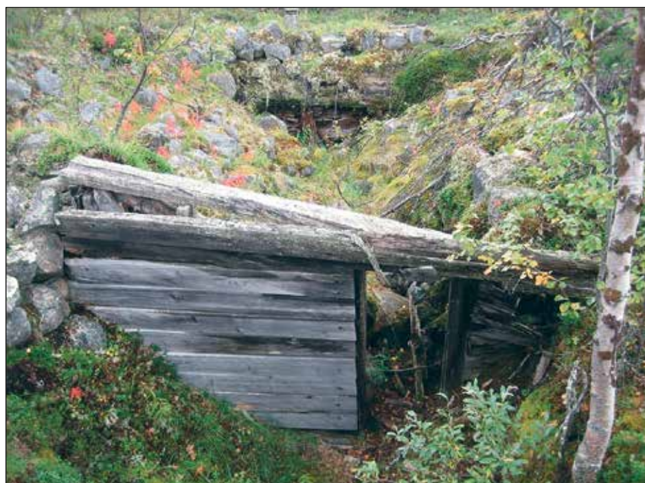
Majoituskorsu kivikatteineen Palkkisvaaran pohjoispuolella "218er Höhellä". Hirsirakenteet ovat antaneet perää kivikatteen painolle. Korsu kuului varmaan niihin, jotka Schulerin kertoman mukaan miinoitettiin, mutta ei hävitetty.
