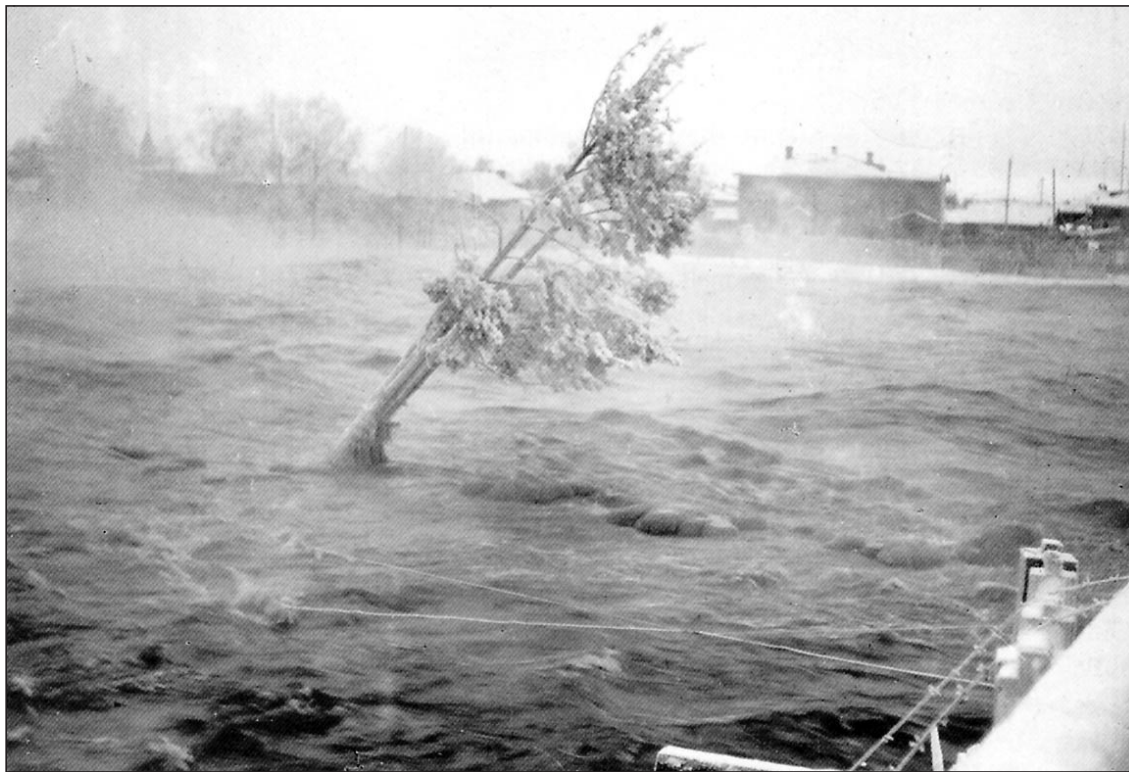
Aamuyöllä 8.12.1941 Poventsasta vetäytyvät venäläiset räjäyttivät Stalinin kanavan sulut. Lähes neljäkymmenen asteen pakkasessa valtava hyökyaalto pyyhkäisi läpi Poventsan aiheuttaen sekä miestappioita että suuria aineellisia vahinkoja. SA-Kuva.
