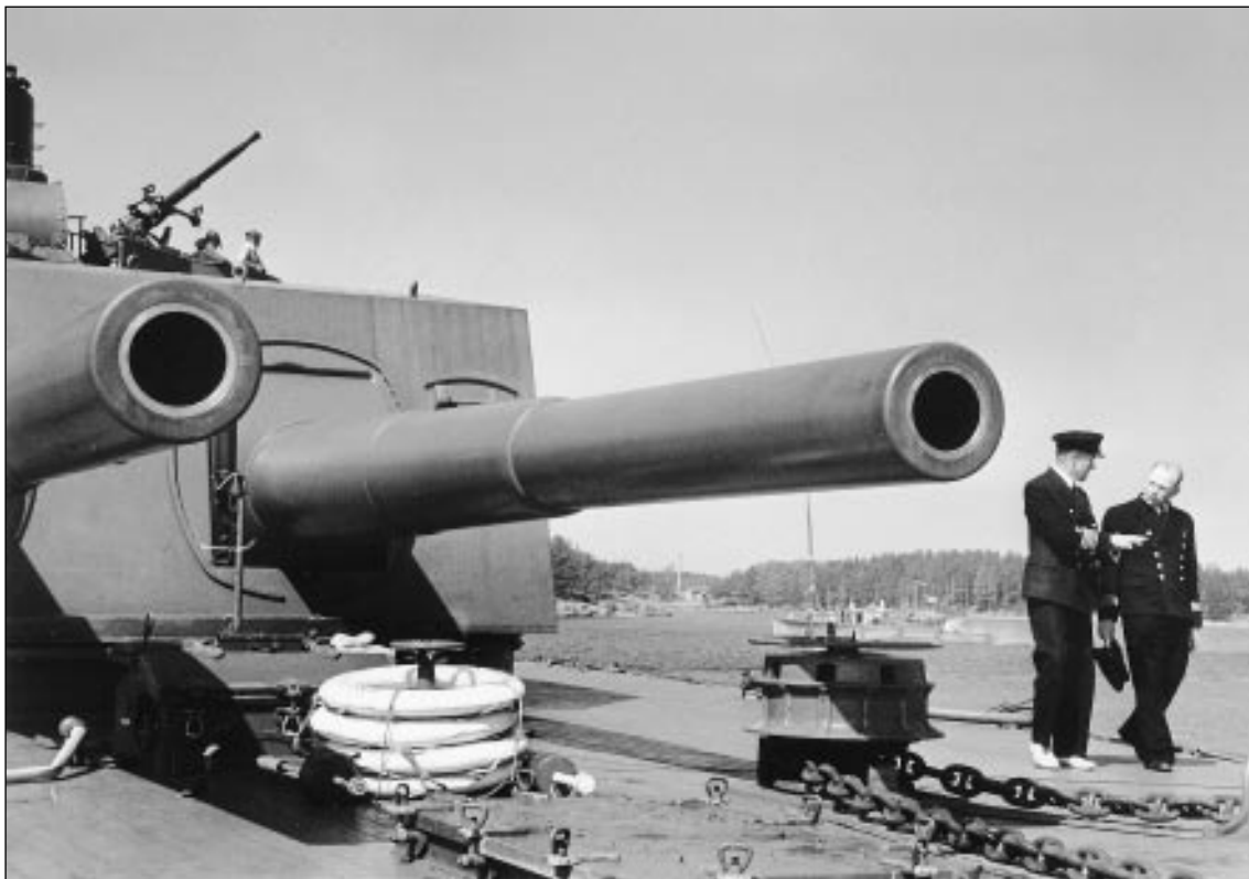
Panssarilaiva Väinämöinen oli varustettu tehokkaalla tykistöllä – neljä 254 ja kahdeksan 105 millimetrin tykkiä. Väinämöinen oli Ahvenanmaan vesillä kevään 1944 rauhantunnustelujen aikaan sekä uudelleen syksyllä aselepoa solmittaessa. SA-kuva
