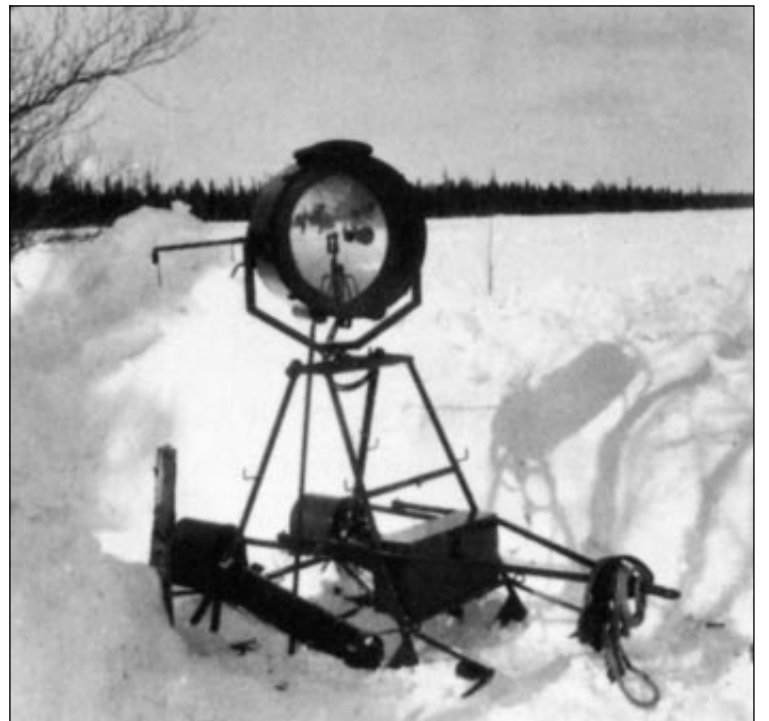
Jääkenttien valvonnassa käytetty kevyt valonheitin Ratsuväkiprikaatin lohkolta Sungunniemeltä. – Kuva: WSOY Jatkosodan historia osa 6.
