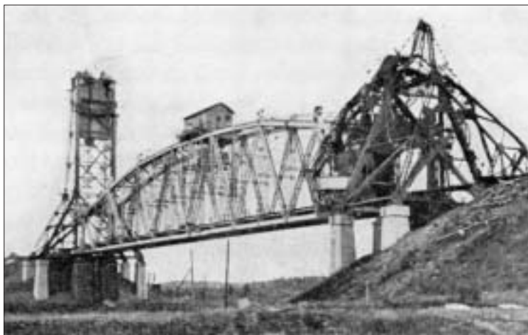
Muurmannin radan silta Podporozessa Syvärillä. Silta oli ehjä suomalaisten saadessa sen haltuunsa 8.9.1941, mutta neuvostokoneiden hyökkäys tuhosi muutamaa päivää myöhemmin sillan nostotorneista toisen. Silta-kaaren päällä on konehuone, josta hoidettiin nostokoneistoa. Niin kutsuttu vastapainosilta oli amerikkalaista alkuperää. Kuva: Suomen Sota 1941-1945, 2.osa.
