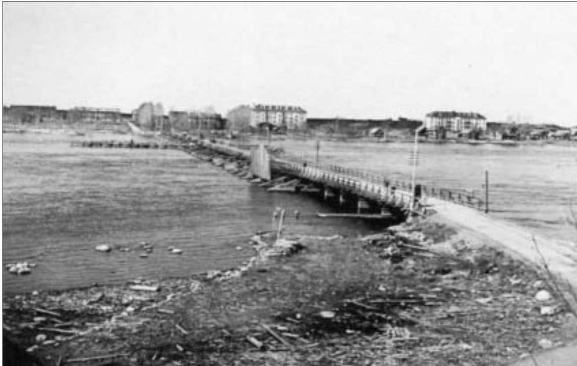
Vuolaasti virtaavan Syvärin suulla Vosnesenjassa huhtikuun 1942 alussa avatulla sillalla oli pituutta lähes 400 metriä. Ajoinan leveys oli kuusi metriä ja sillan kantavuus 12 tonnia. Taustalla näkyy joen etelärannalla oleva Vosnesenjan kaupunki. SA-kuva.
