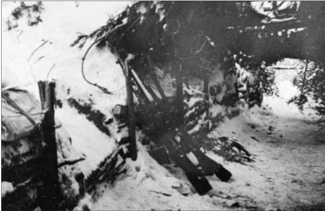
Naamiokatoksella varustettu ampumahauta Oinalassa helmikuun alkupäivinä. (Kuva kirjasta Talvisodan historia 2, WSOY 1978).
